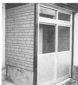
修理された風除室
