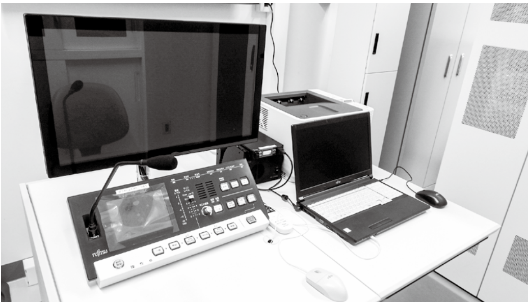
ふるさと総合センター内に設置された新デジタル防災行政無線親局 (戸別受信機は8ページに掲載)
