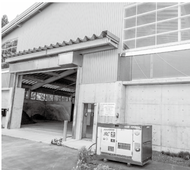
残渣処理施設にあるリースのコンプレッサー
