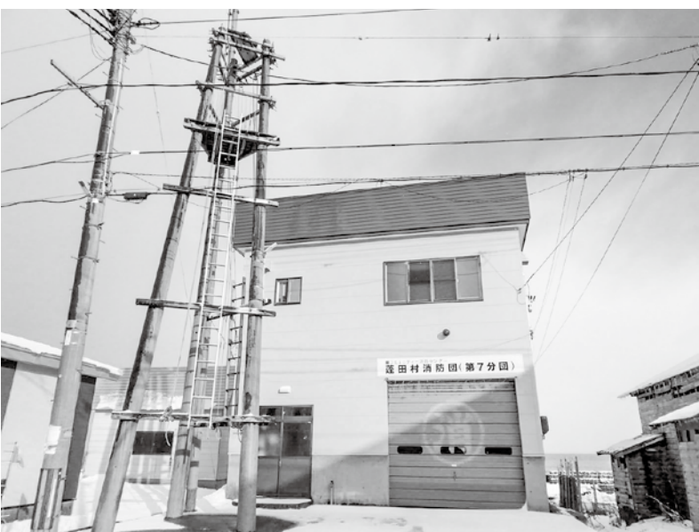
改修工事を終えた広瀬地区消防団屯所
