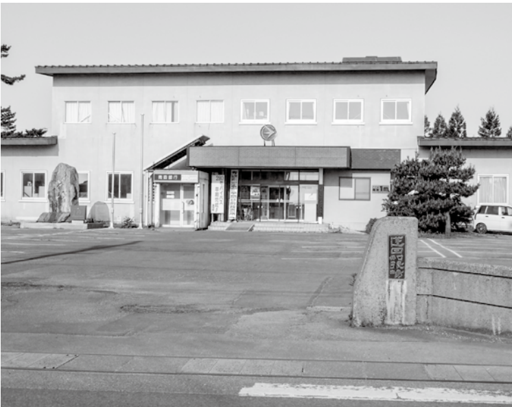
築50年を経過した役場庁舎
