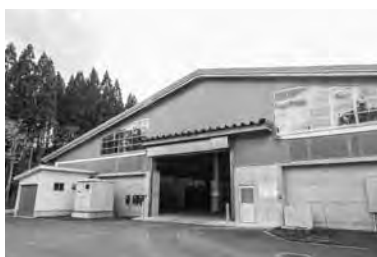
村ホタテガイ養殖残渣堆肥化処理施設
