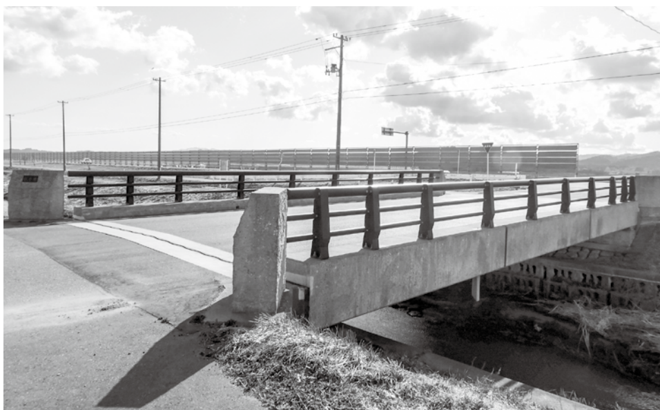
修繕を終えた中沢地区の観音橋
