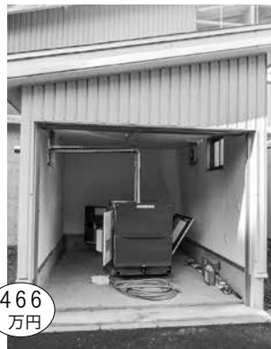
堆肥化処理施設 コンプレッサー設置工事
