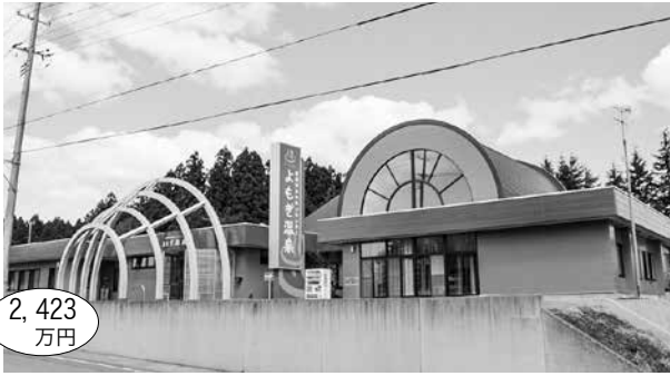
ふれあいセンター井水ポンプ等改修工事
