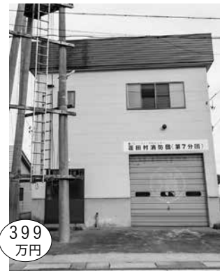
第7分団屯所改修工事
