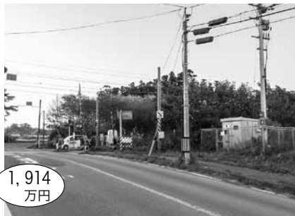
郷沢融雪施設キュービクル建替工事
