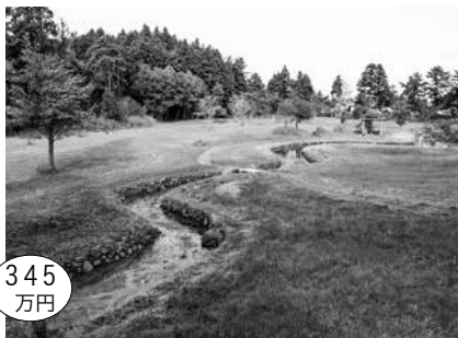
カントリーパーク整地工事
