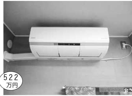
温泉のエアコン等設置
