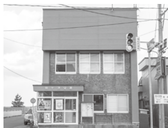
広域消防外ヶ浜分署
