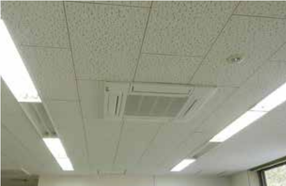
ふるさと総合センターの空調機が新設されました。
