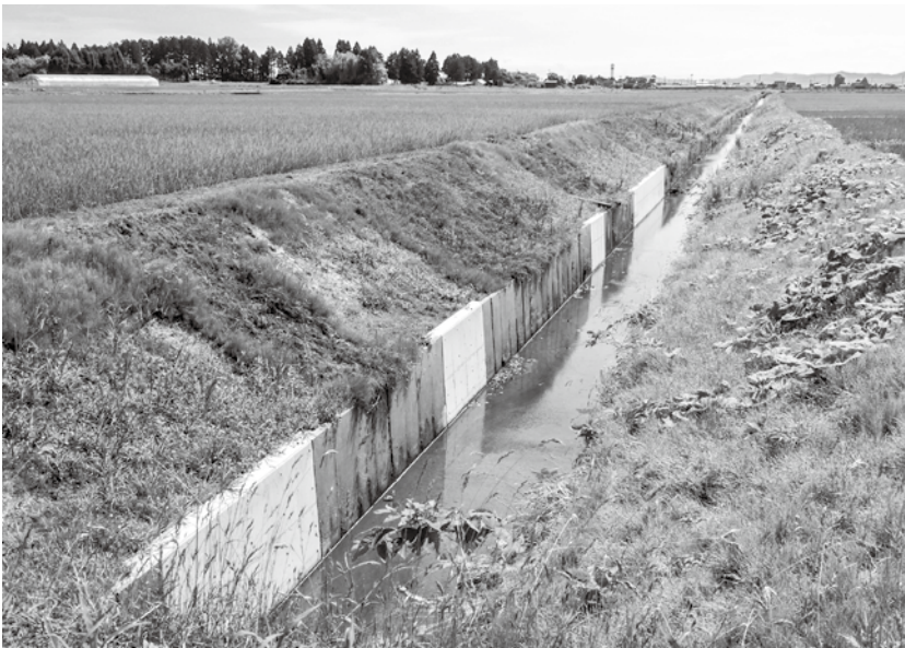
崩落して急きょ工事した箇所
