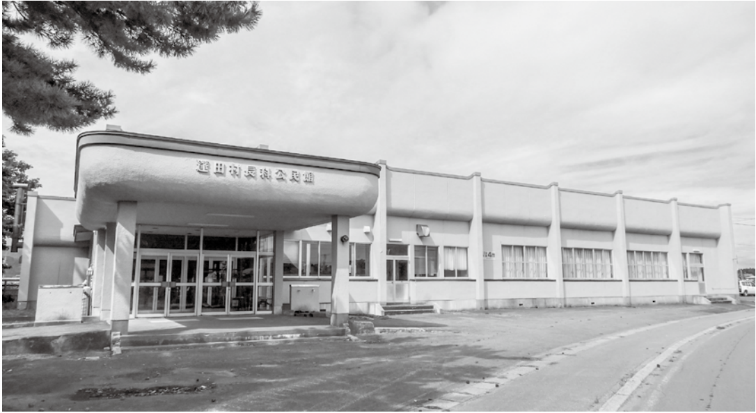
長科新公民館。40年以上前に建てられた建物はアスベストが使用されている
