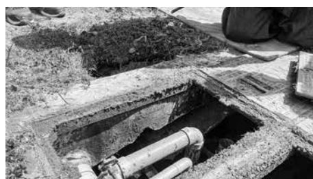
補修を行う箇所
