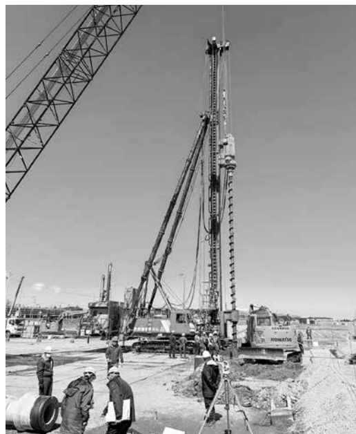
3月28日 杭打ち工事
