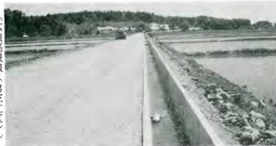
(広瀬高根線(第二工区))
