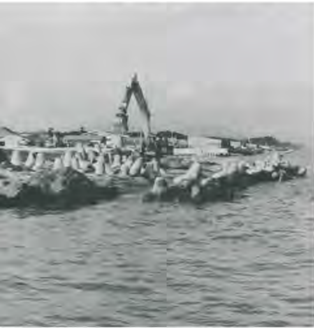
……建設中の郷沢工区船揚げ場……
