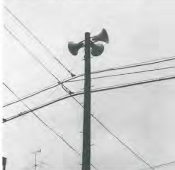
… 老朽化してきた有線放送施設 …
