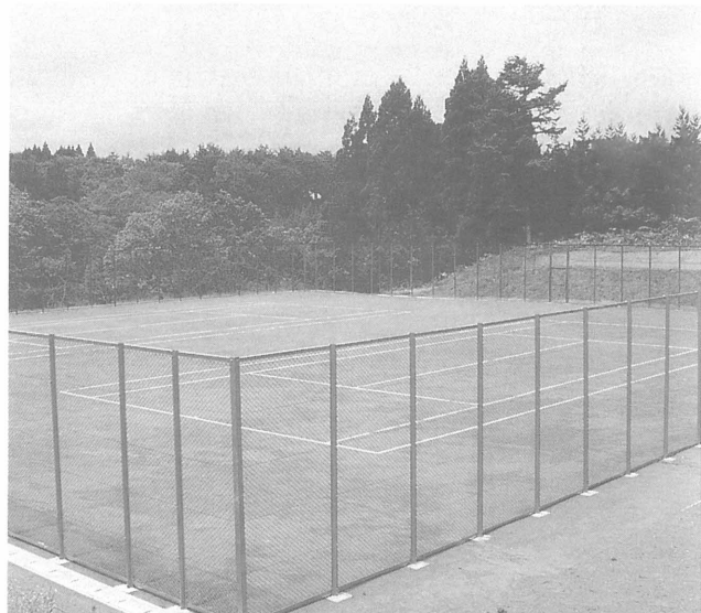
フェンス張りのテニスコート2面
