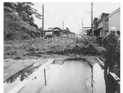
瀬辺地、広瀬間の土砂崩れ
