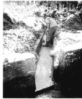
▶ 中沢地区の用水路の泥上げ
