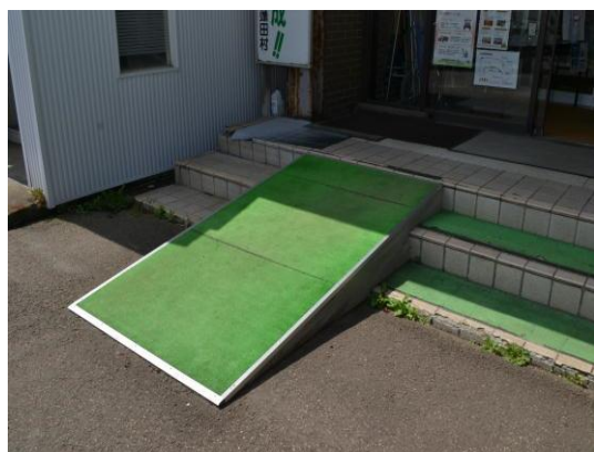
正面入口スロープ
