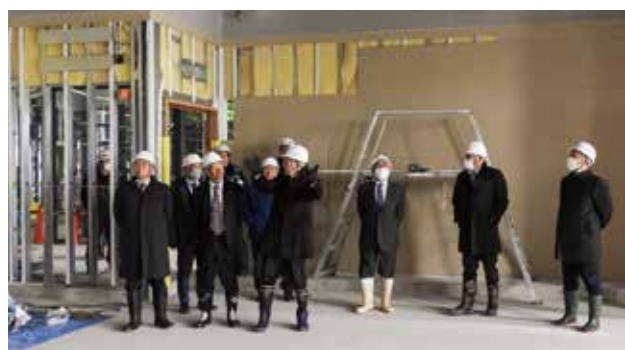
3月7日 役場新庁舎建設現場視察
