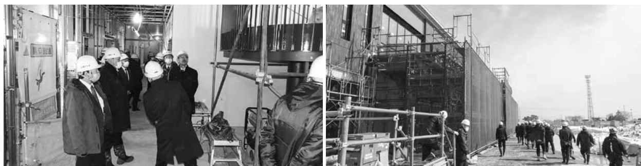
新庁舎建設現場の様子
