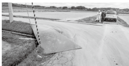
十字路の角は鉄板が敷かれた状態
