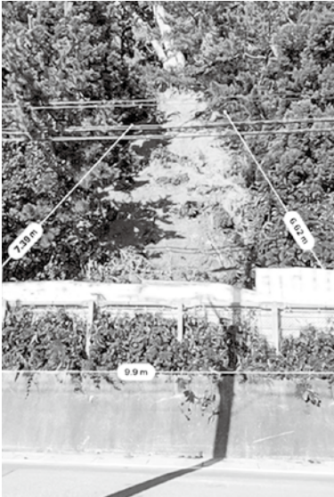
瀬辺地地区の土砂崩れ現場 すぐそばを国道280号が通っている
