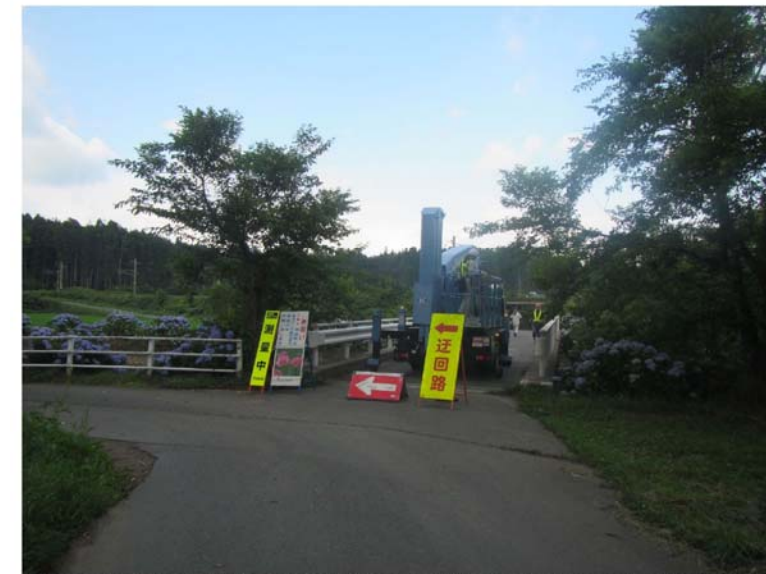
橋梁点検車使用状況写真
