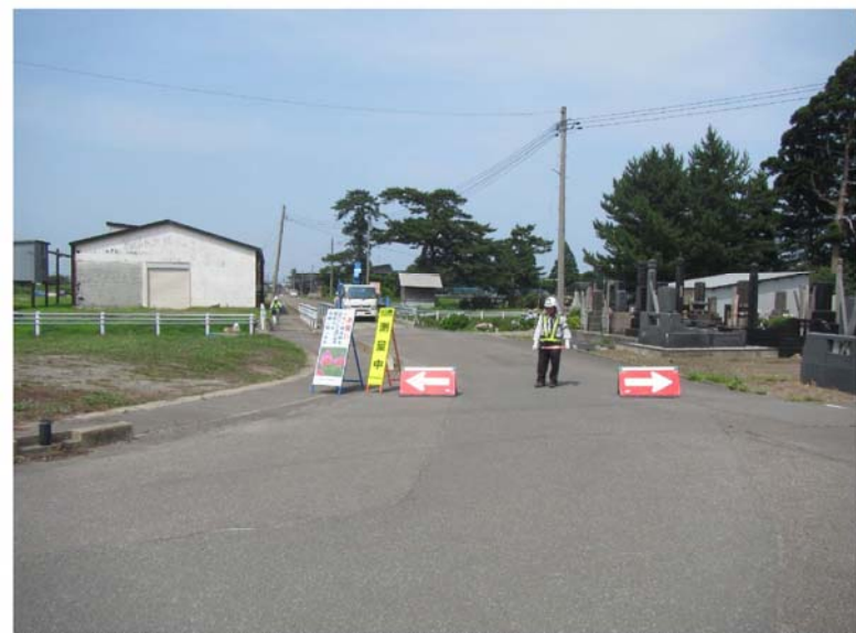
橋梁点検車使用状況写真
