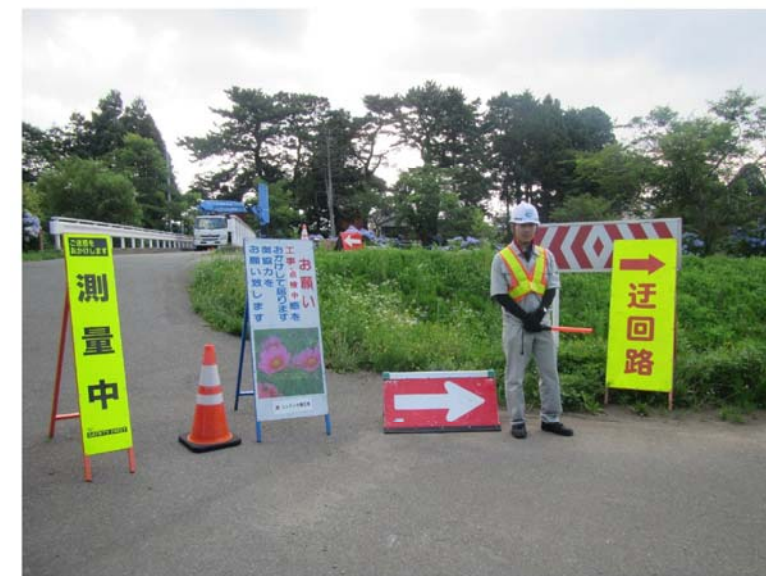
橋梁点検車使用状況写真
