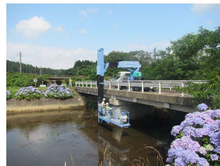
橋梁点検車使用状況写真
