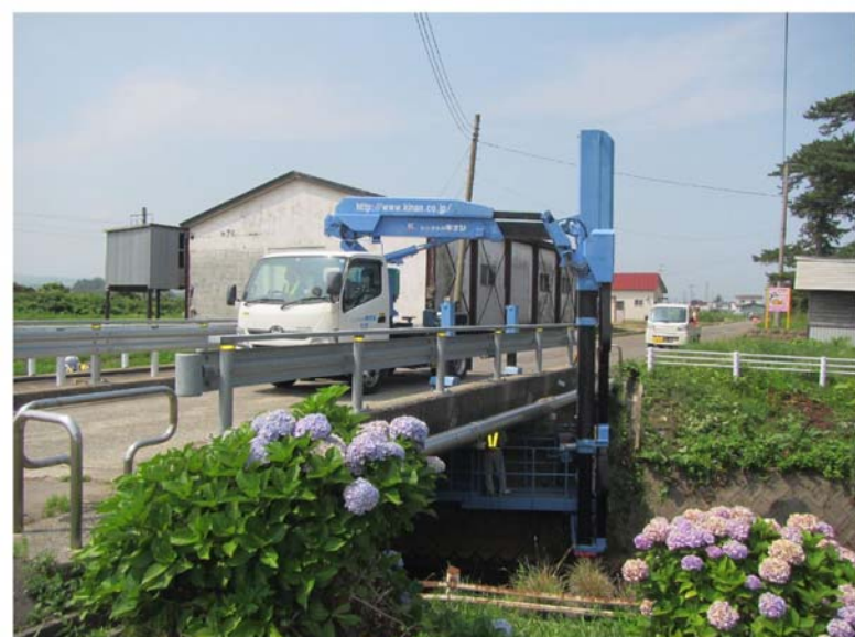
橋梁点検車使用状況写真
