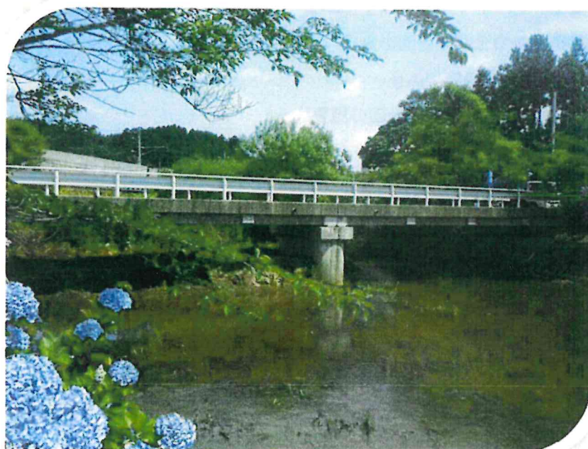
八幡橋（広瀬川）
