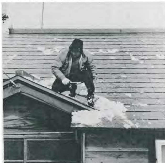
小さな破損箇所は次いでに修理
