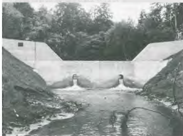
瀬辺地小川平治山ダム (長さ28m・高さ4m・体積213m 3 )
