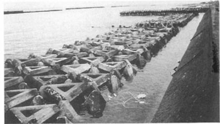
現在、瀬辺地変電所下の海岸に中空三角ブロック（1個の重さ約2ト）を海に沈める作業が進められています。この作業は、青森工事事務所、海岸出張所が担当していますが、この三角ブロックは、ヤマセの強い時などの、波しぶきを防止することが出来るそうです。また、いずれこの海岸にも砂が付いて遠浅になってくれればという期待もあるそうです。
