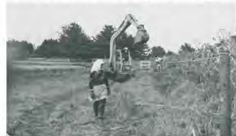
▲郷沢稲荷神社附近の新設農道工事
