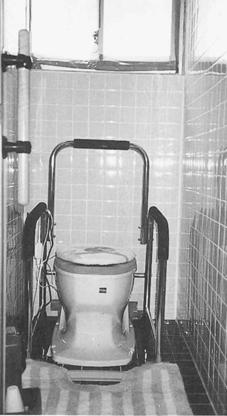
洋式便座に安全手すりを取り付け、入り口にも、縦に1本手すりをつけた例です。
