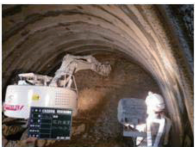
④掘削状況
