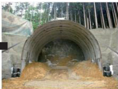
③坑口付完了
