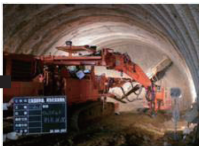
⑥ロックボルト打設
