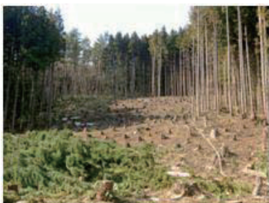
①施工前状況
