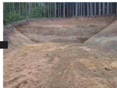
②坑口部切土完了
