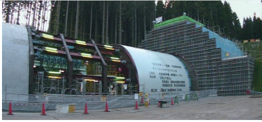
▲発進前のシールドマシン。右が発進坑口
