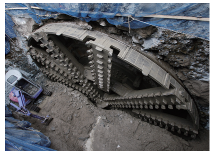
▲中間立坑に到着した掘削機。ここでビット交換などをし、シールドマシンを埋め戻して、再び発進！
