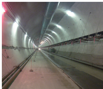
▲完成したトンネル内。ここに新幹線が走るレールがひかれていきます。
