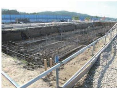
③地中梁工事
