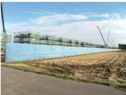
中沢地区工事状況 (平成23年10月上旬撮影)
