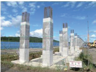
④柱部工事
