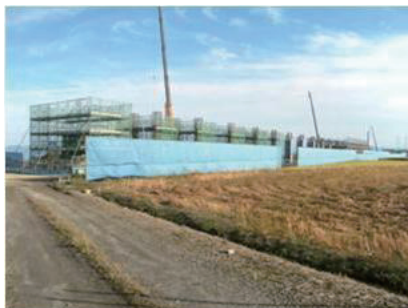
長科地区工事状況 (平成23年10月上旬撮影)
