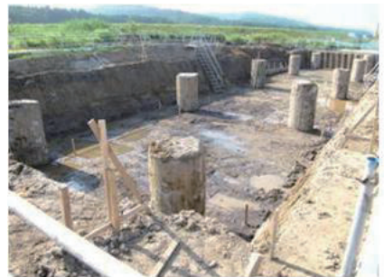
②掘削状況
