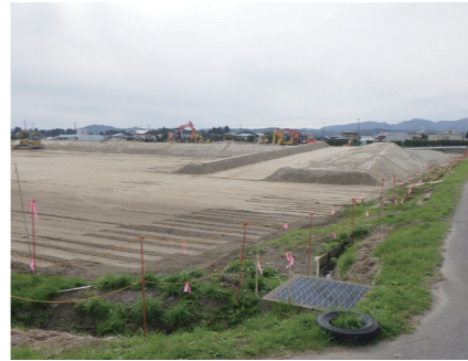
▲令和7年の開庁に向けて工事は進んでいます
